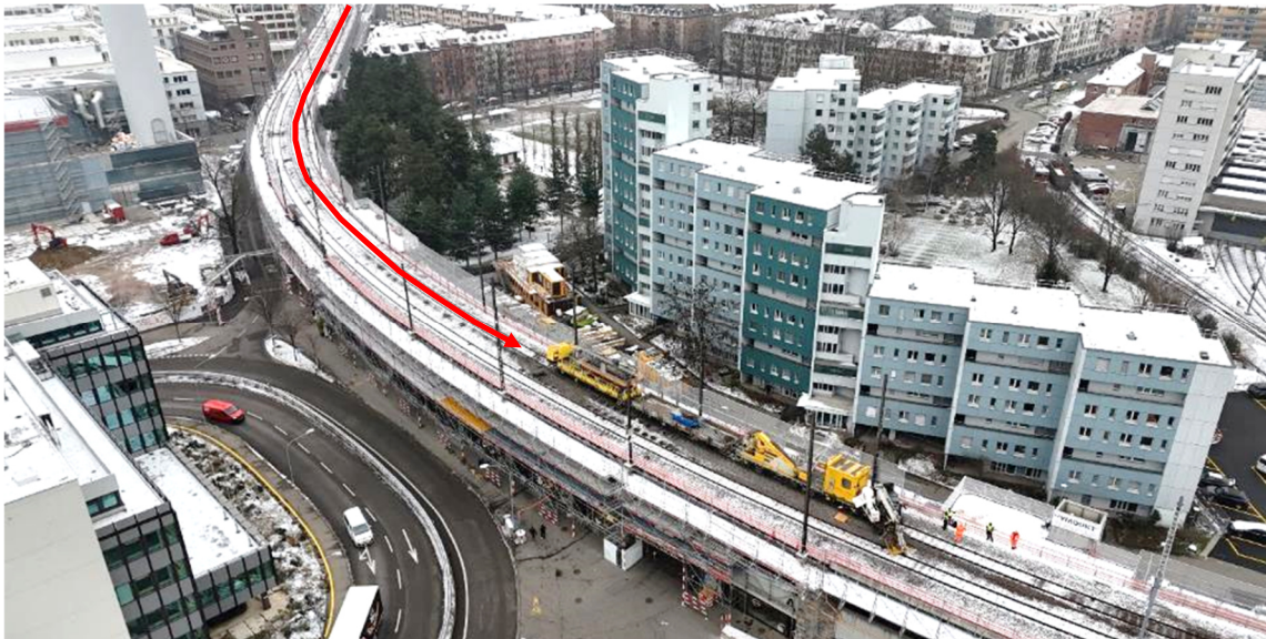
Abbildung 4: Übersicht beim Wipkingerviadukt: Rollweg der Komposition 2 (roter Pfeil).
