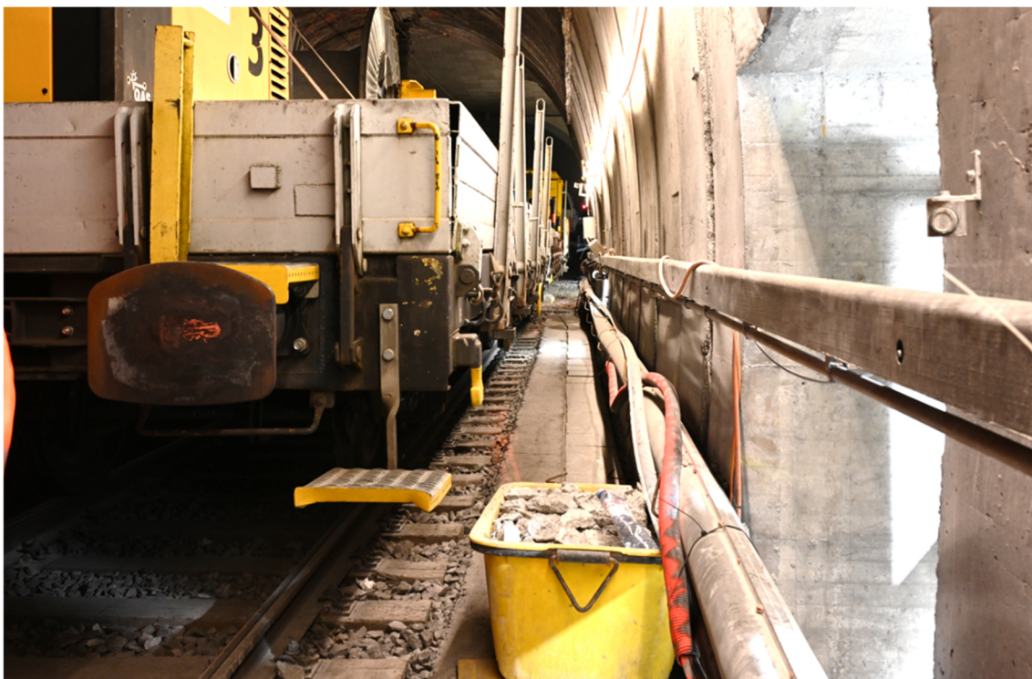
Abbildung 8: Bankett an der Tunnelwand als Gehweg, mit Hindernissen belegt und enge Platzverhältnisse.
