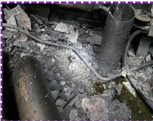
Abbildung 7: Lok Re 450 025. Die Kunststoffleitung fehlt. Öl am Boden im Maschinenraum.
