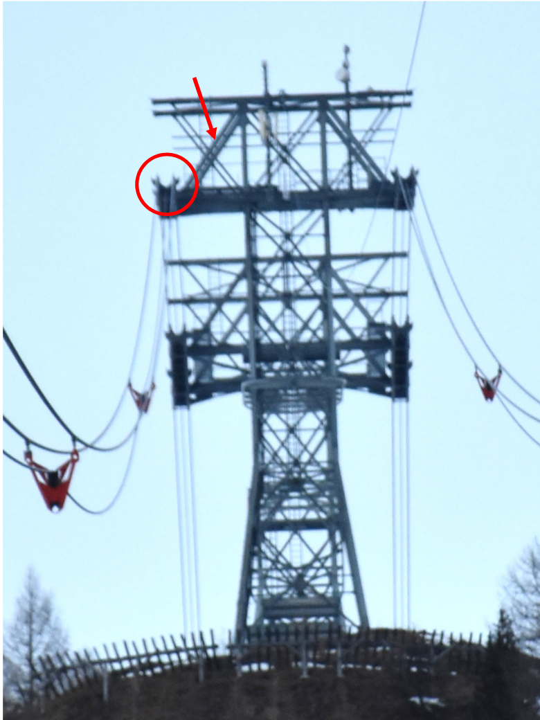
Abbildung 2: Seilbahnstütze 1, vom Tal Richtung Bergstation gesehen: Arbeitsstelle am linken, unteren Seilsattel (Kreis) und Verstrebung der Stütze (Pfeil).
