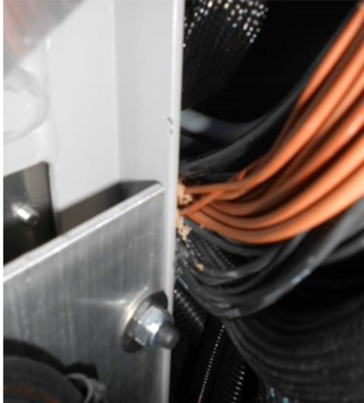
Illustration 8 : Trolleybus N° 9. Câbles endommagés près du tableau électrique situé derrière le siège conducteur.
