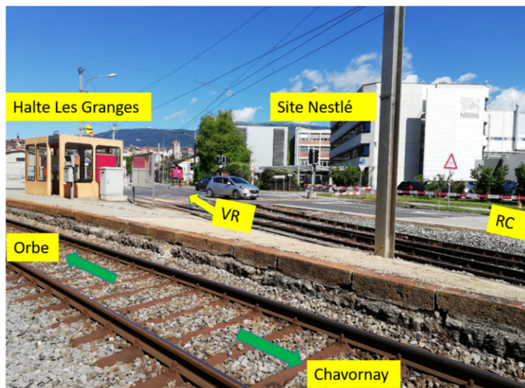
Illustration 3 : Vue générale du carrefour de Longeraie avant réaménagement. (Source : TRAVYS, adjonctions SESE.)
