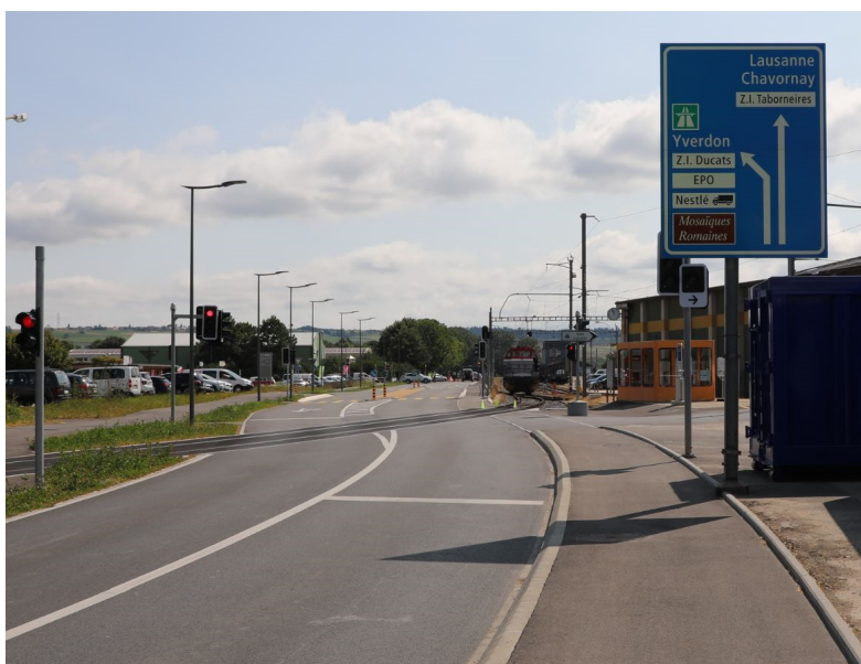
Illustration 6 : Vue du carrefour réaménagé. Sur la droite, le nouveau trottoir qui croise la VR Nestlé en direction de Chavornay. Sur la gauche, la piste cyclable. Au milieu la route cantonale.
