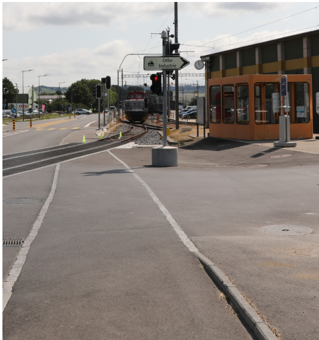
Illustration 15 : Feu piéton, absence de marquage de la ligne d'arrêt au sol sur le trottoir.
