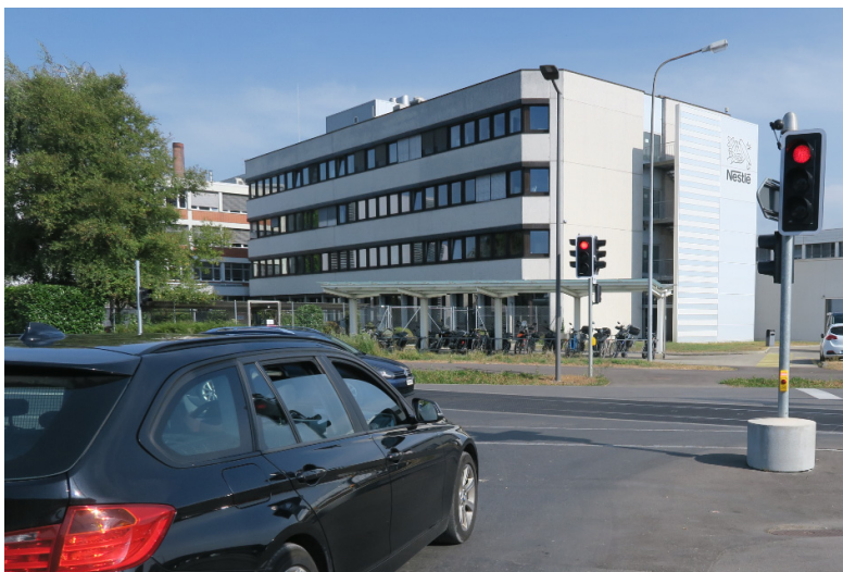
Illustration 17 : Ligne d'arrêt manquante au sol.
