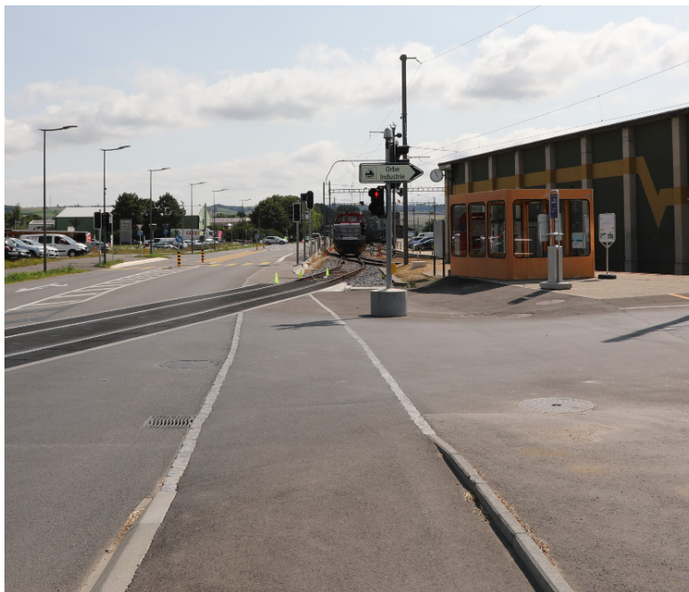
Illustration 12 : Vue du feu de signalisation piétonnier au rouge lorsqu'un itinéraire de manœuvre est établi sur la voie de raccordement. Aucun marquage au sol n'est appliqué sur le trottoir. (Source : Police VD.)
