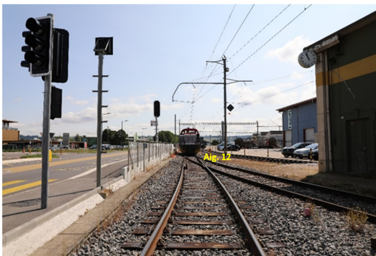
Illustration 11 : La limite de la voie de raccordement se situe au talon de l'aiguille N° 12. (Source : Police VD, adjonctions SESE.)
