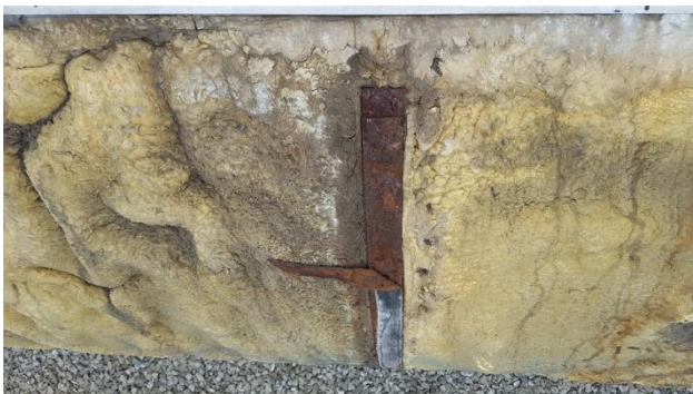
Abbildung 3: Tragring mit Korrosion.
