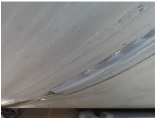
Abbildung 6: Detail der geklebten Verbindungsstelle zweier Blechsegmente.
