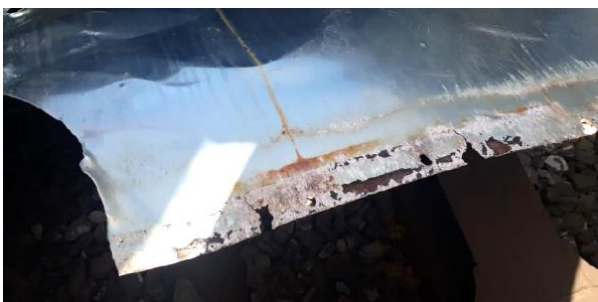
Abbildung 4: Korrodierte Verbindung und ausgerissene Nietstellen der Blechverschalung.
