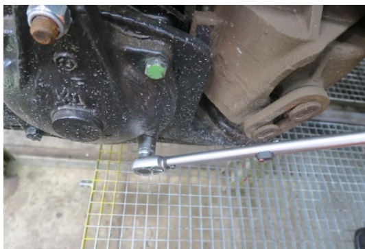
Abbildung 24: Überprüfung des Anzugsmoments der Achslagerdeckelschrauben.
