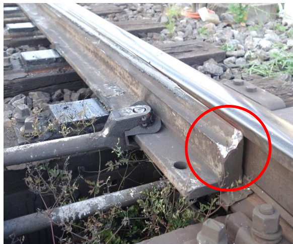
Abbildung 5: Aufprallspur an der Zungenspitze der Weiche 190
