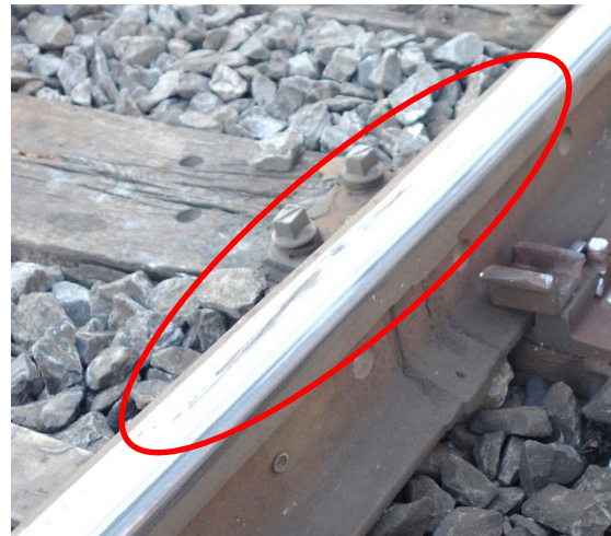
Abbildung 4: Farbabrieb auf dem Schienenkopf
