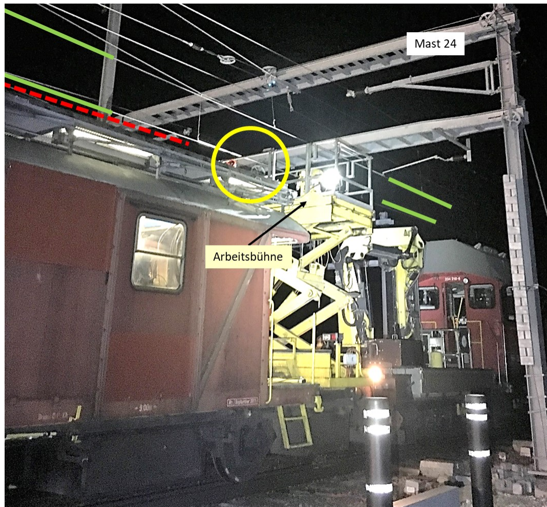
Abbildung 5: Arbeitsstelle nach dem Unfall (Quelle: Kantonspolizei VS, bearbeitet durch SUST).
