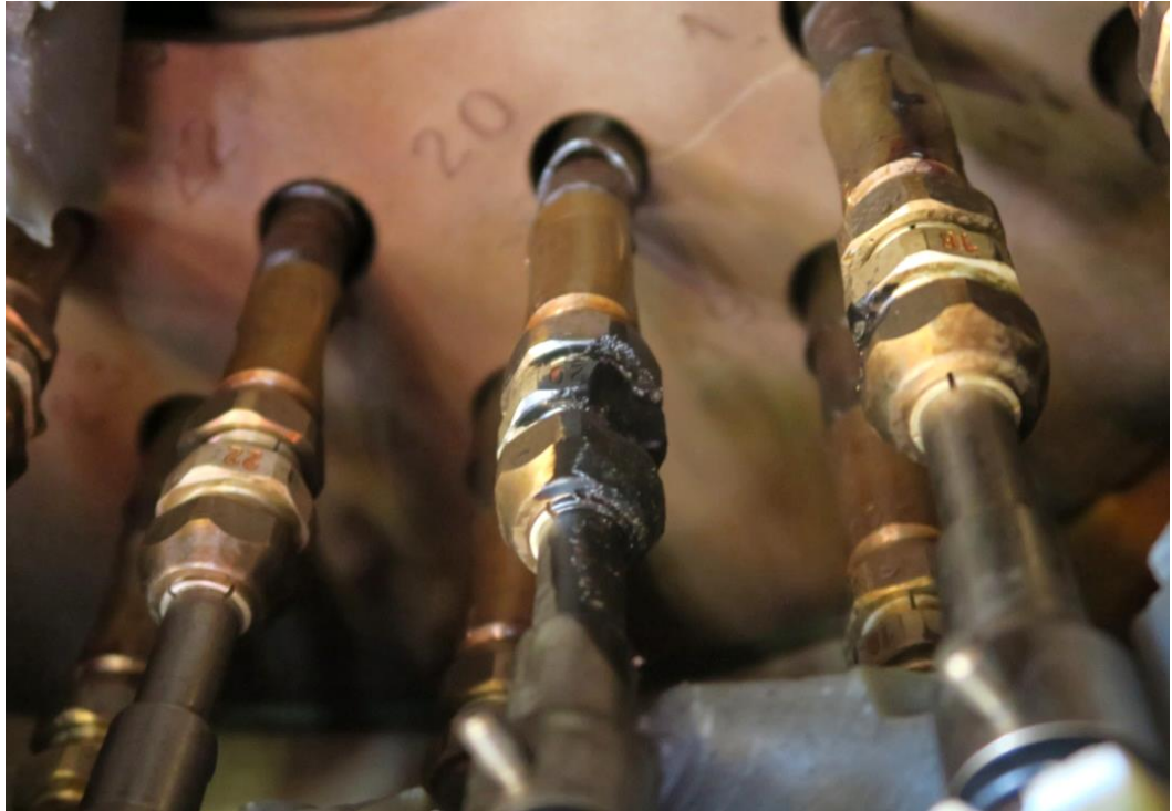
Abbildung 5: Brandspuren auf den Anschlussbolzen des Stufenschalters.
