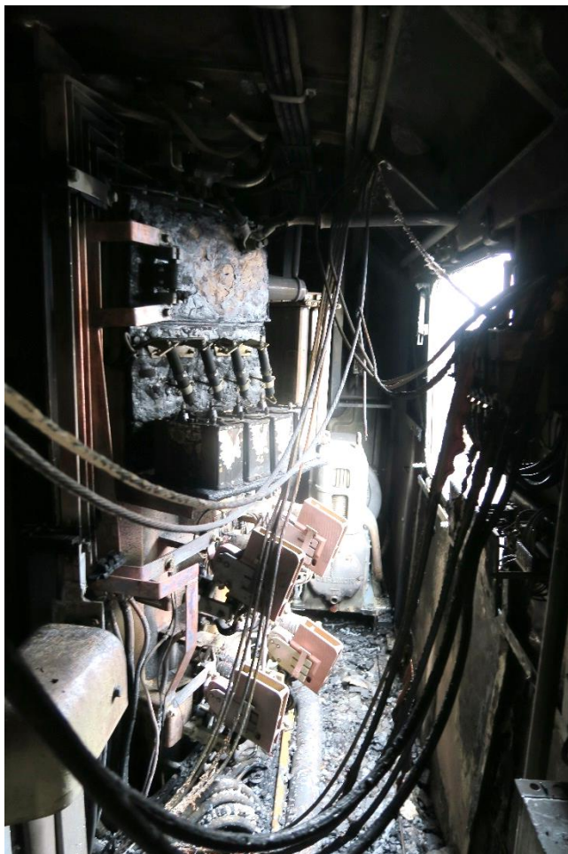
Abbildung 6: Schaden im Maschinenraum.
