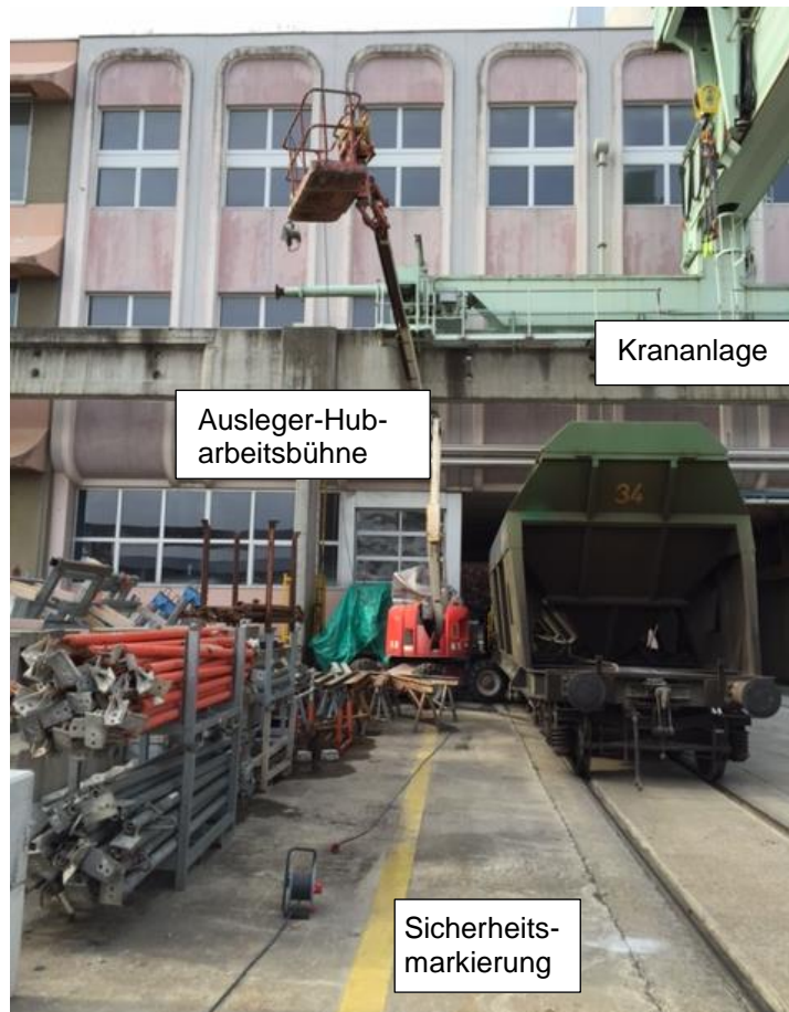
Abbildung 5: Blick auf die Unfallstelle. Im Bild sichtbar ist auf der linken Seite die Ausleger-Hubarbeitsbühne, auf der rechten Seite sind der vorderste Güterwagen der Wagengruppe und die Krananlage zu sehen. Ausserdem ist die gelbe Sicherheitsmarkierung erkennbar.
