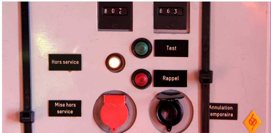
Illustration 3: appareil automatique des trains hors service.
