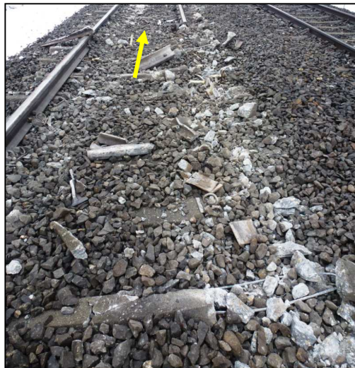
Abbildungen 4 + 5: Massive Schäden an der Schiene rechts (Quelle: SUST).
