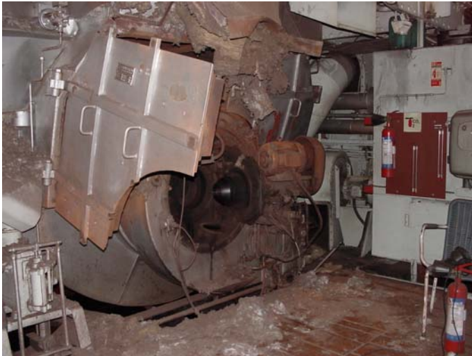
Foyer de la chaudière endommagé.
