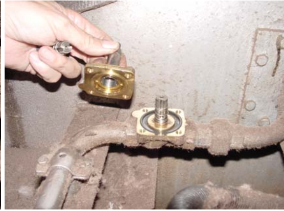
Vanne avec obturateur et membrane
