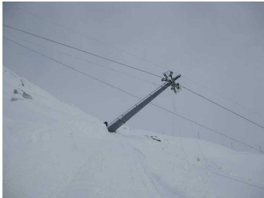
Abbildung 2: Stütze 17 am 2. Februar 2012
