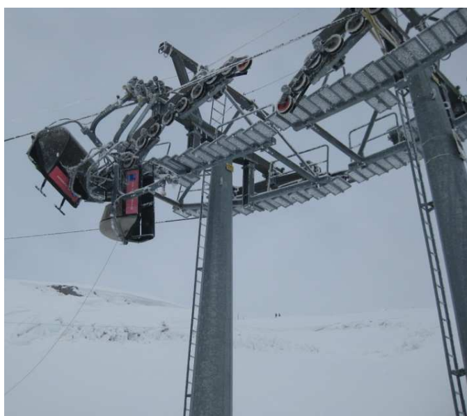
Abbildung 3: Stütze 16 mit verklemmten Sesseln
