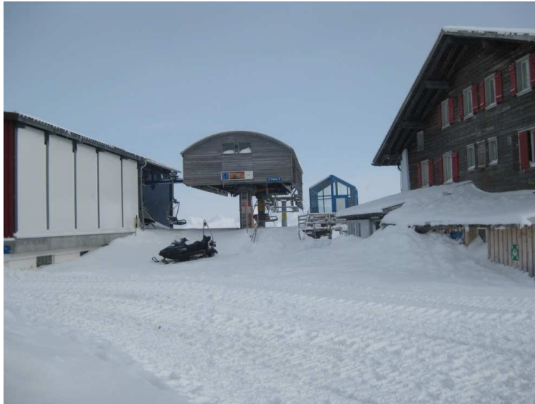
Abbildung 5: Bergstation - Antrieb mit Sesselgarage links
