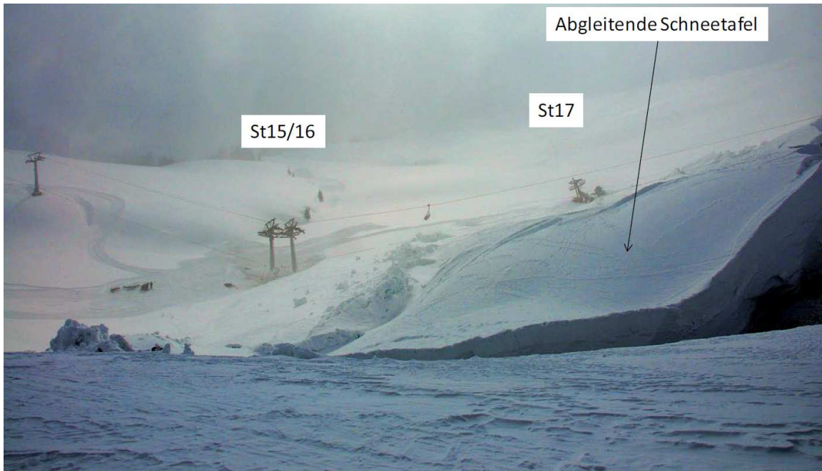
Abbildung 9: "Blick von oben auf die abgleitende Schneetafel. Zwischen den Stützen 15/16 und 17 hat sich die Schneedecke markant nach oben gewölbt (Stauchwall). Unterhalb des Stauchwalles dürfte sich die Schneedecke nicht verschoben haben." Foto und Legende SLF
