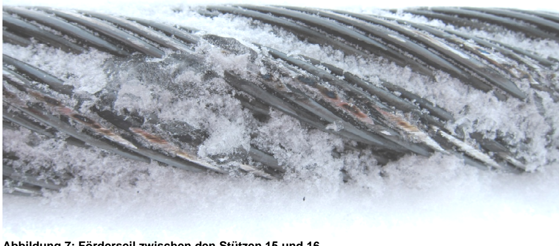
Abbildung 7: Förderseil zwischen den Stützen 15 und 16
