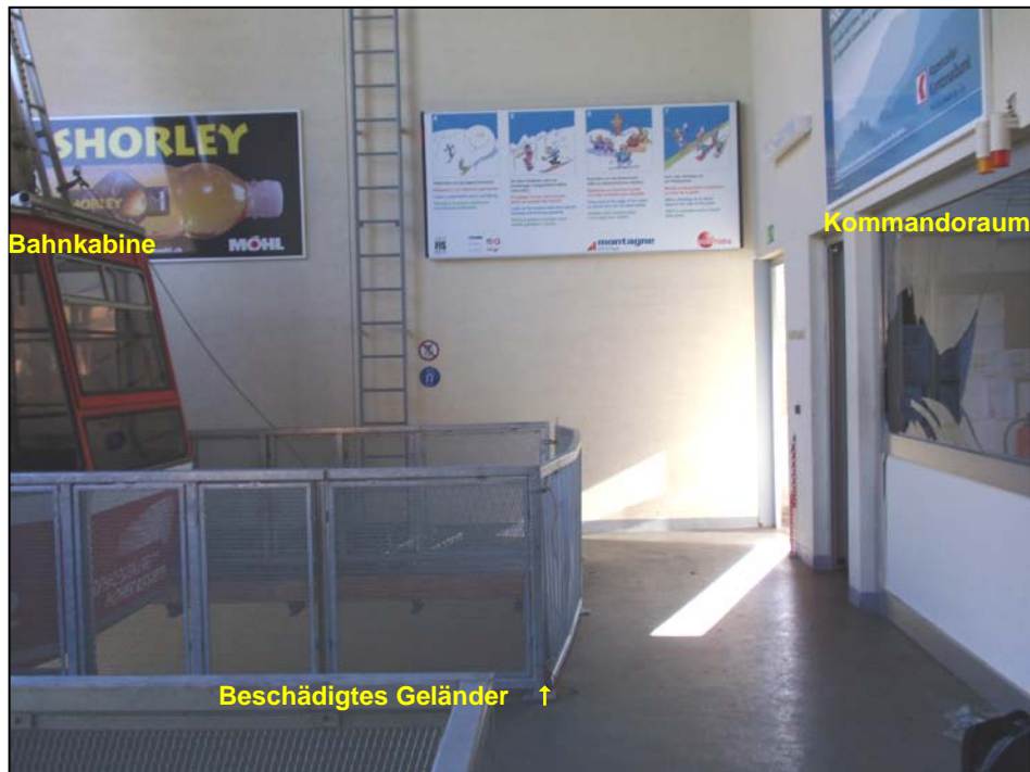
Talstation HKDS (beschädigtes Geländer provisorisch wieder eingehängt) Foto: UUS, zej
