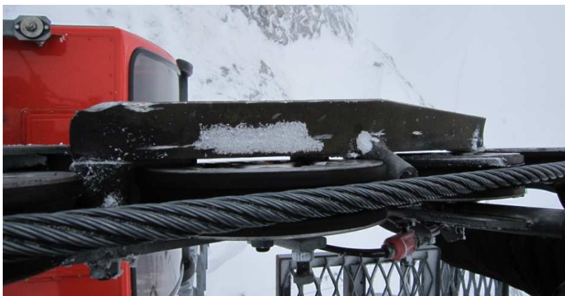
Foto 14: Schleifspuren am talseitigen Seilfänger
