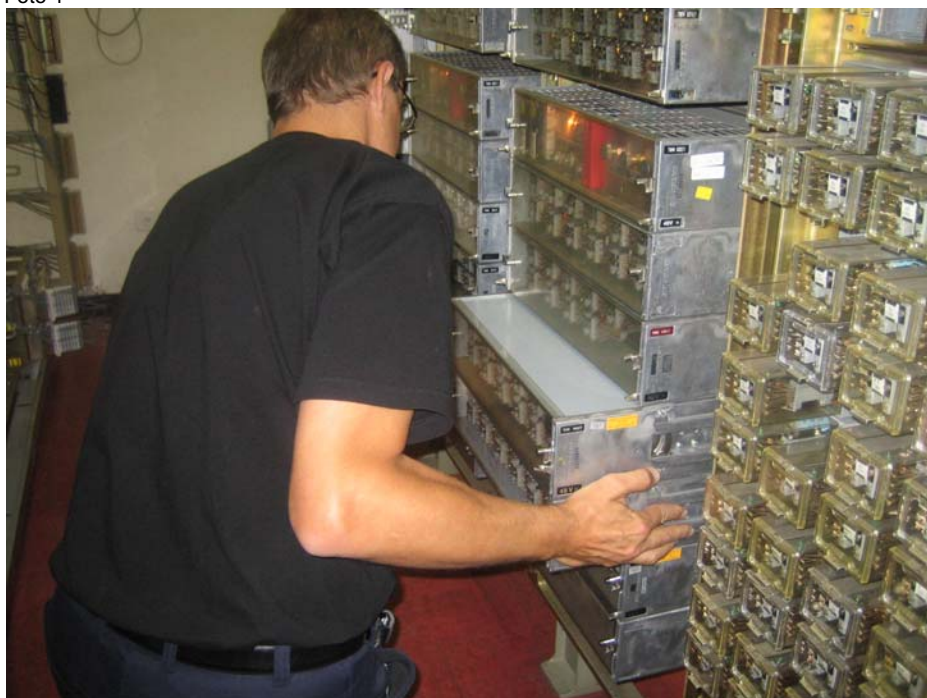
Auswechseln des Relaissatzes im Relaisraum Mumpf.
