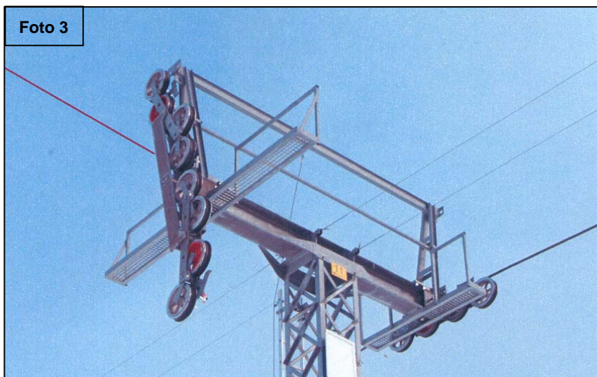
Stellung Rollenbatterie an der Stütze 11 nach dem Unfall
