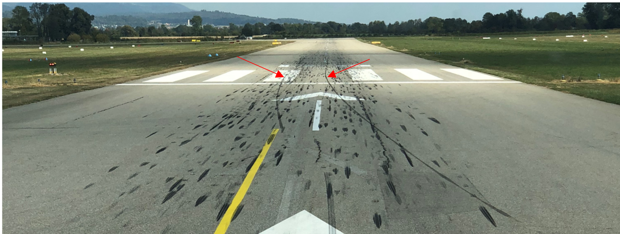
Abbildung 5: Bremsspuren der SP-YGI (rote Pfeile) im Bereich der Pistenschwelle 06, Blickrichtung entgegengesetzt der Landerichtung 24.
