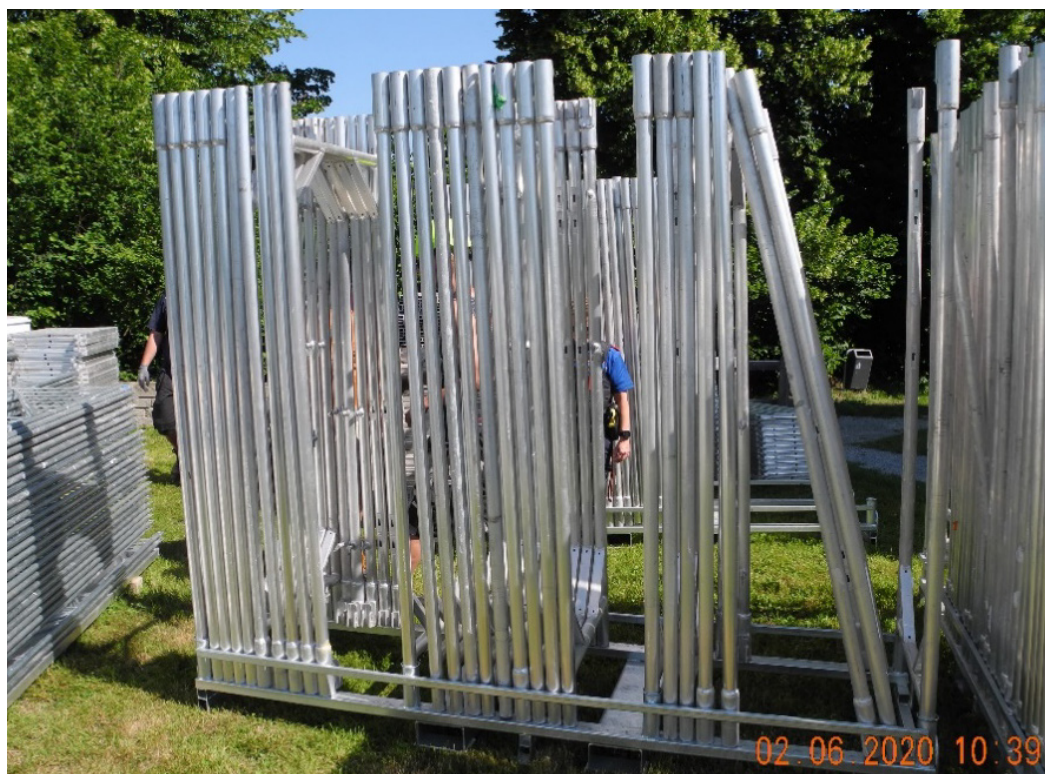
Abbildung 2: Barelle am Abladeort ohne Spanngurt nach dem Teilverlust der Gerüstelemente
