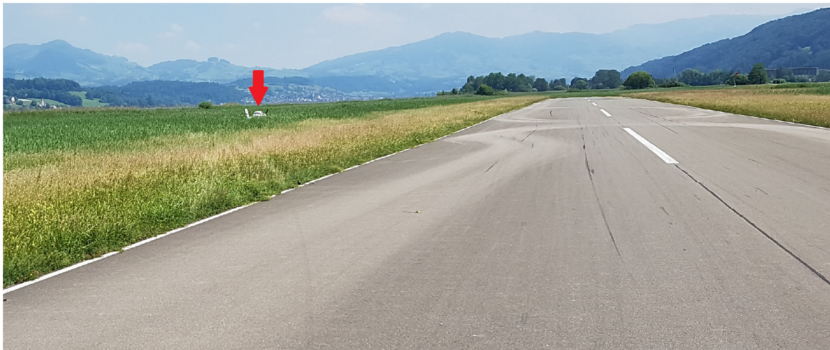
Abbildung 2: Endlage des Flugzeugs HB-SGT links der Piste 08 des Flugplatzes Wangen-Lachen. Auf dem Pistenabschnitt im Vordergrund sowie im angrenzenden Wiesland sind Spuren des Fahrwerks erkennbar.
