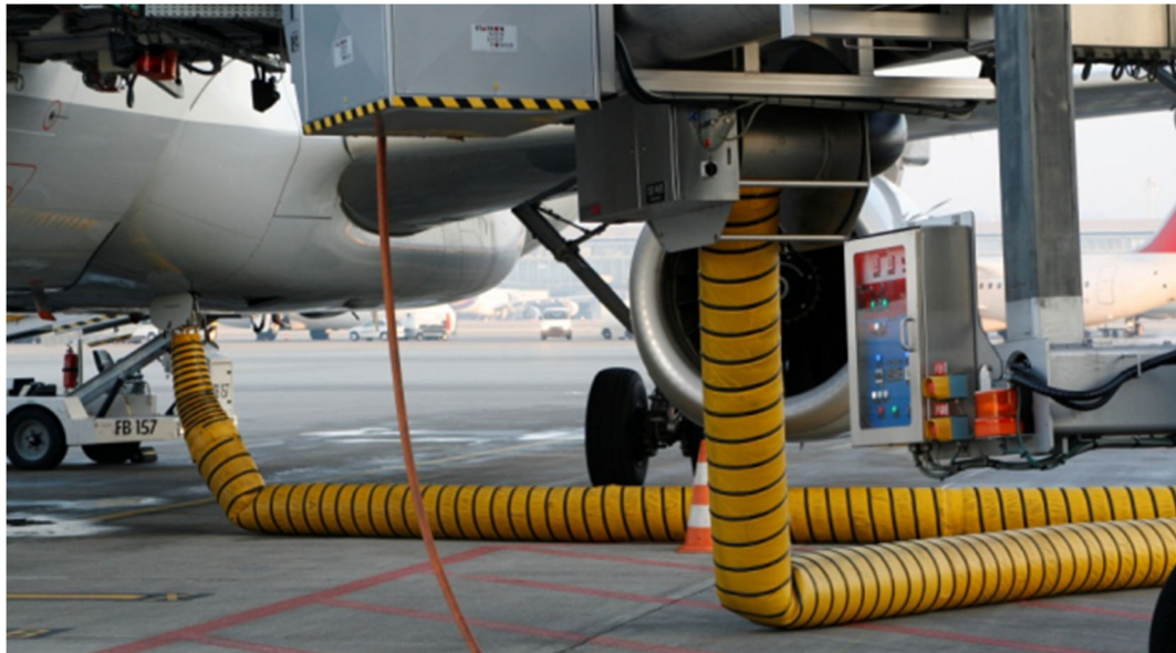
Abbildung 5: Luftschlauch des pre-conditioned air system , der an die Bodenluftanschlüsse ( low pressure ground connector ) angeschlossen ist. Quelle: Flughafen Zürich.
