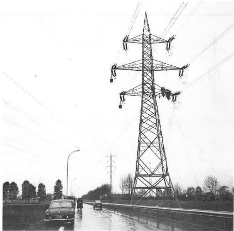
Vues prises en direction de l'impact montrant la route industrielle et le pylone 524 de l'EOS avec le fuselage de l'avion HB-SPD encastré dans la console inférieure droite du pylone.
