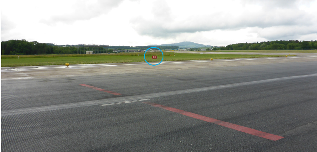
Abbildung 5: Rote Linie am Boden beidseits der Pistenachse 16/34 (vgl. Abbildung 4, gelber Kreis) sowie rotes Schild mit weisser Aufschrift "10-28" (blauer Kreis), in westnordwestlicher Blickrichtung.
