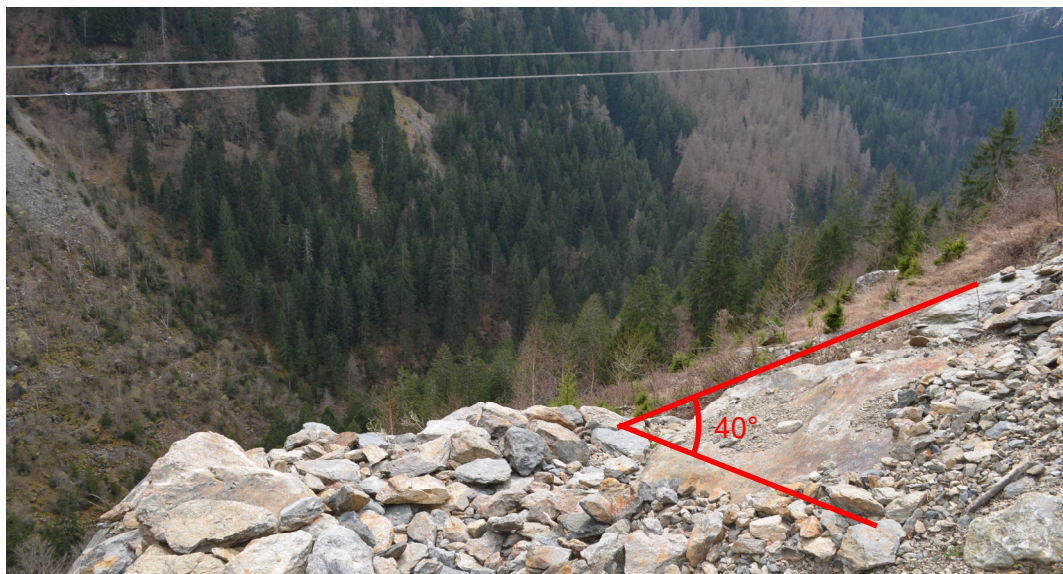
Figure 3 : vue de la place de dépose avec la ligne à haute tension en arrière-plan.
