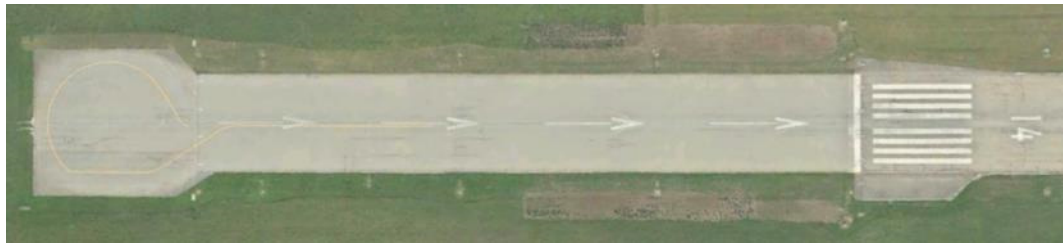
Abbildung 3: Luftaufnahme runway turn pad und versetzte Pistenschwelle Piste 14
