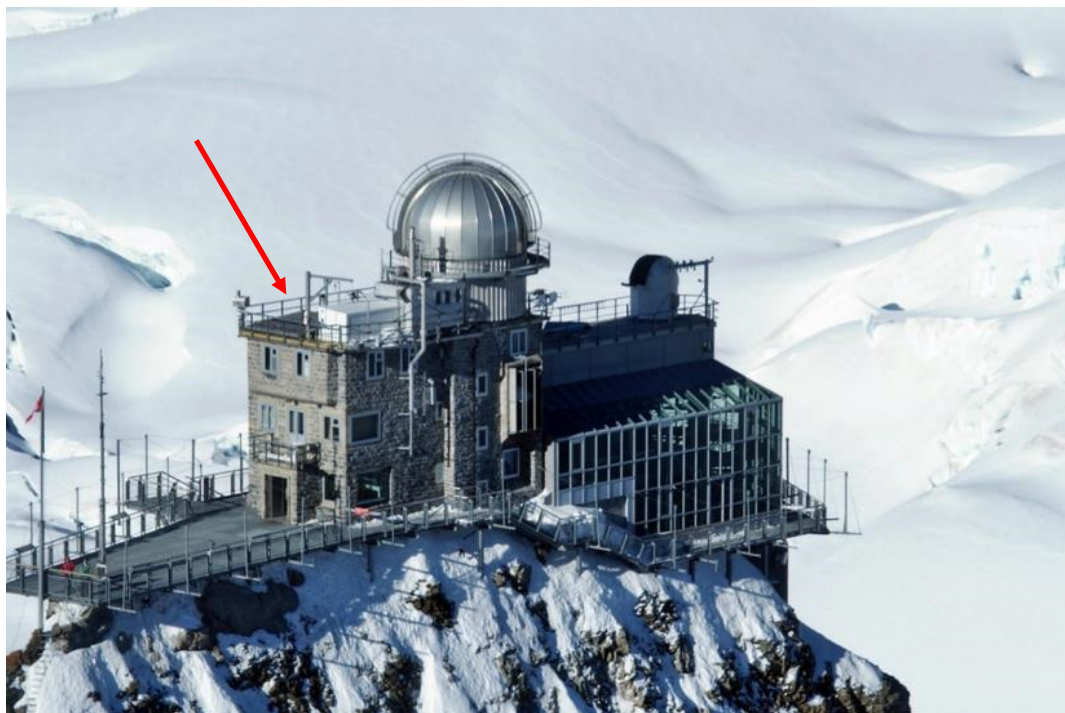
Abbildung 1: Observatorium Sphinx, der rote Pfeil zeigt auf das Dach
