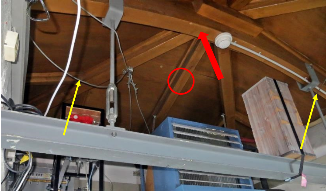
Abbildung 6: Innenansicht des Daches. Der rote, dicke Pfeil zeigt den Hauptträger. Der rote Kreis bezeichnet einen der zwei Dachsparren. Die gelben Pfeile zeigen auf die beiden vormontierten Drahtseilschlingen im Hauptträger.
