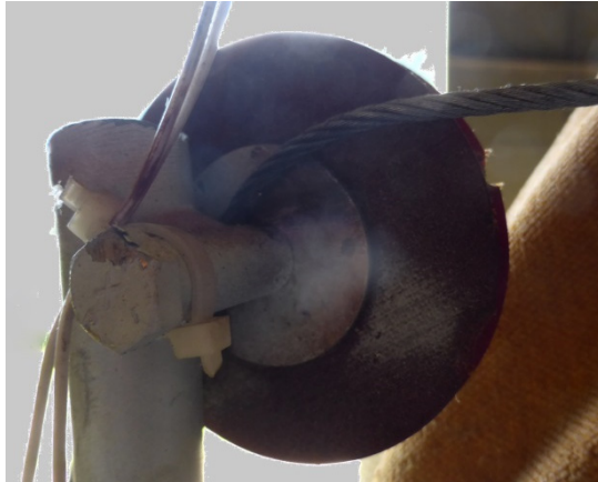
Abbildung 4: Steuerseil ausserhalb der Umlenkrolle vorne oben links
