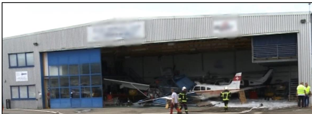
Figure 4 : détail de la porte n° 1 et position finale de l'avion HB-PMR.
