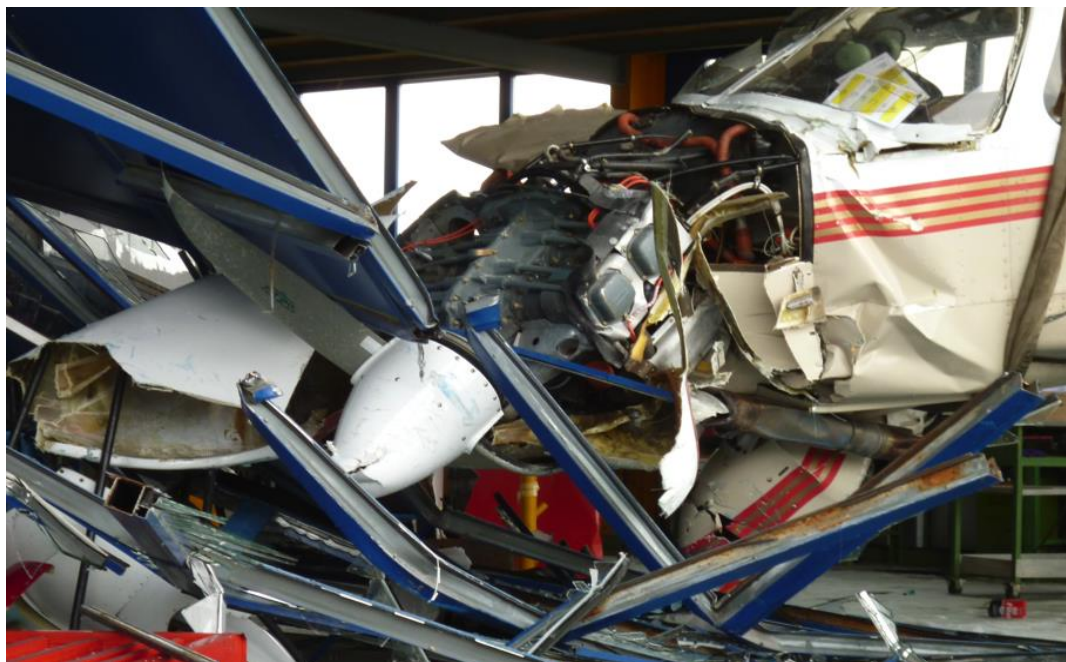
Figure 6 : avant de l'avion et structure métallique des portes du hangar.
