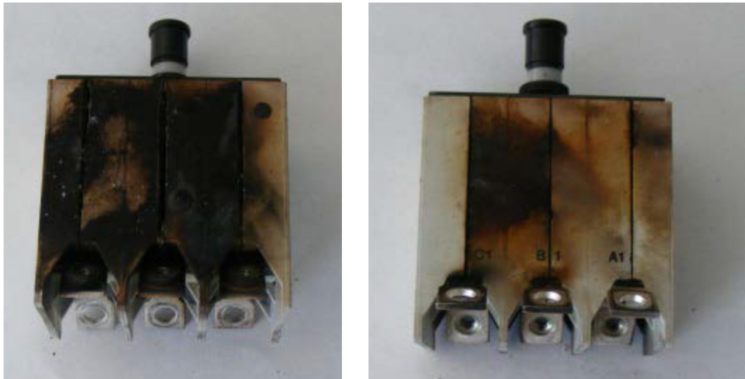
Abbildung 6: Vor- und Rückseite des circuit breaker 3XN1 nach dem Test (Quelle Airbus)
