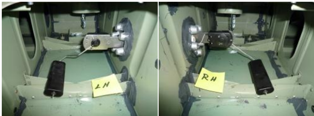
Abbildungen 2 und 3: Seitenverkehrter Einbau der Füllstandsensoren, welcher dazu führte, dass die Schwimmer bei geringem Treibstoffstand auf der Tankstruktur auflagern.
