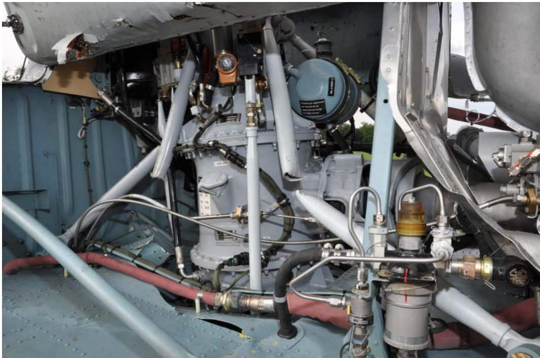
Abbildung 5 – Ansicht auf das Hauptrotorgetriebe und dessen gebrochene Aufhängung
