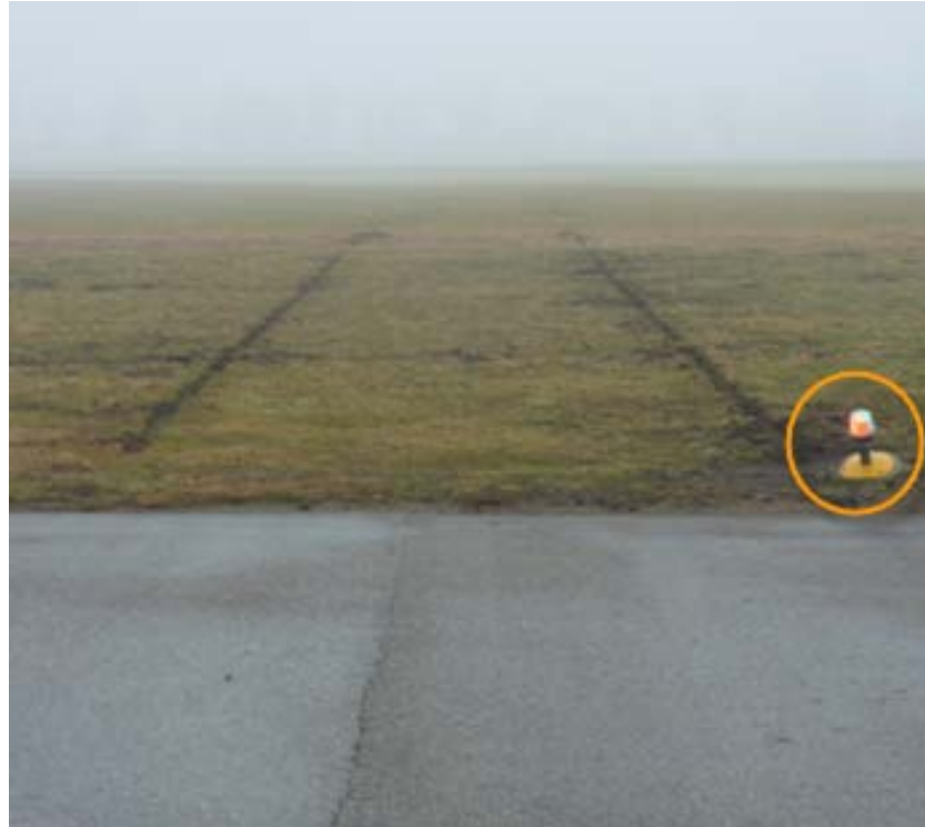
Abbildung 1: Blick in Abflugrichtung am Ende der Piste 07. Im Vordergrund rechts die touchierte Pistenendbefeuerungslampe (orange eingekreist).
