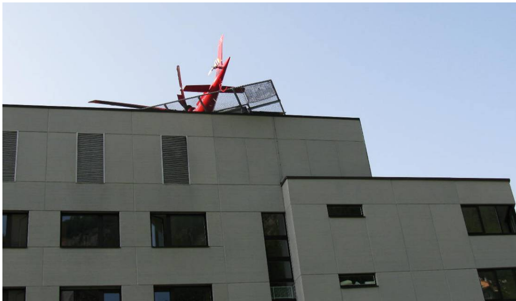
Bild 1: Der beschädigte Helikopter ragt über die Heliplattform und die Gebäudefassade hinaus.
