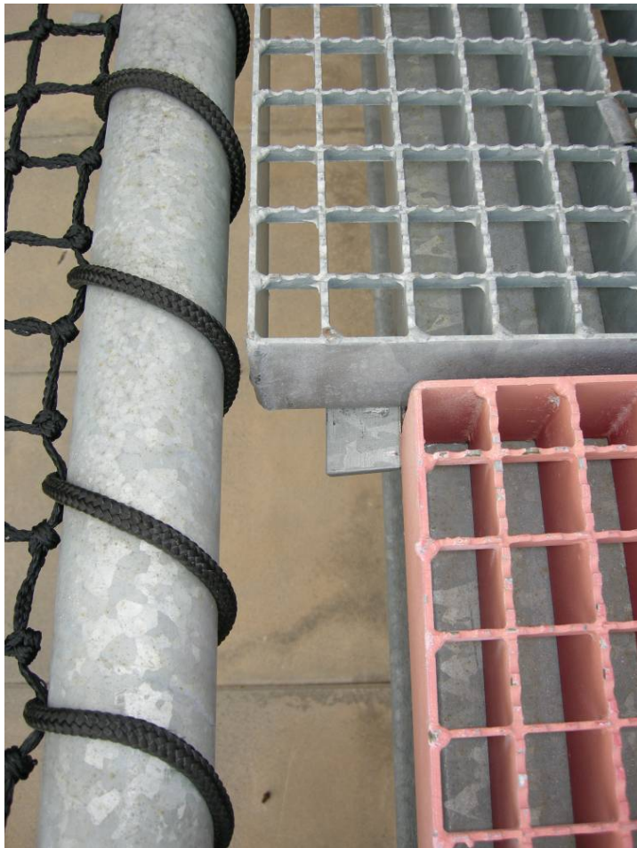
Bild 4: Verschobener Gitterrost
