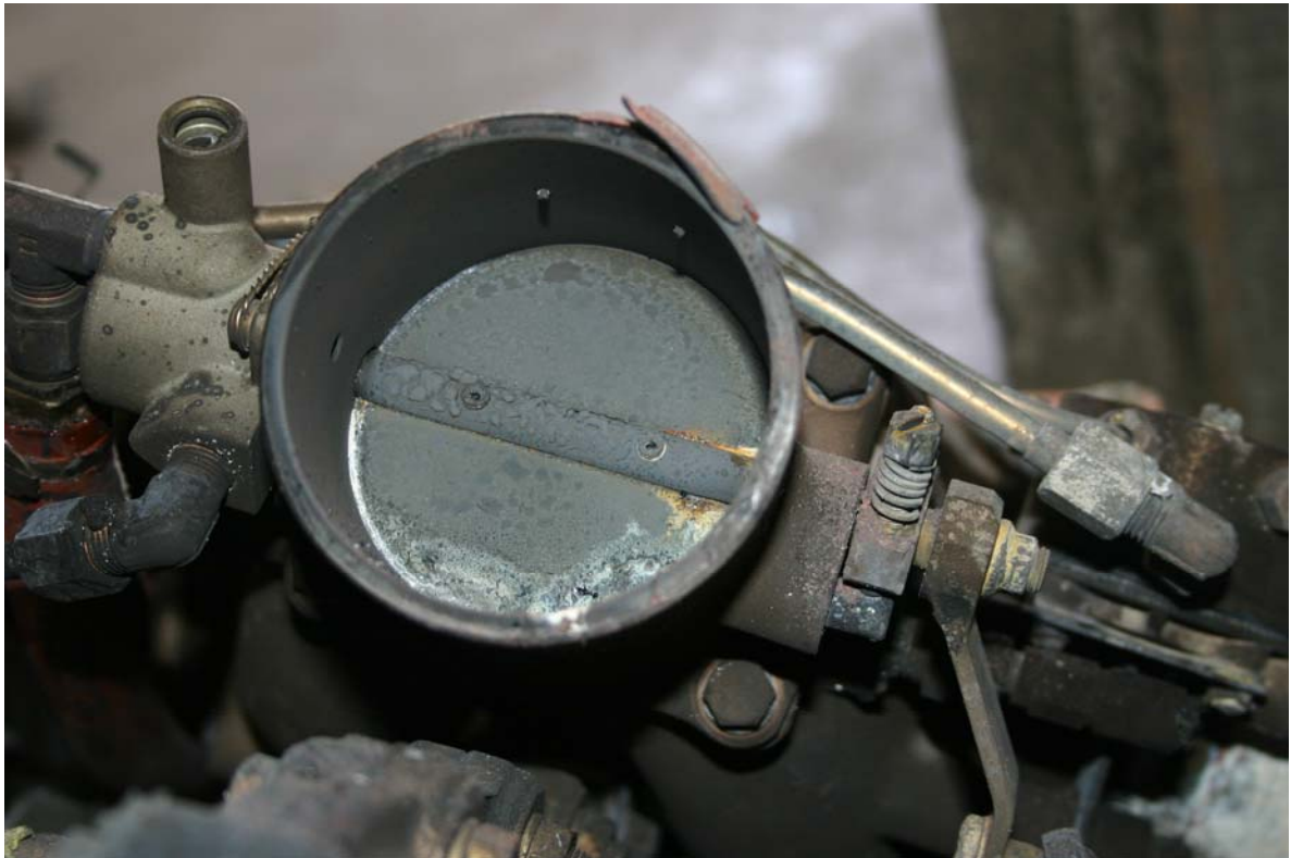
Foto n. 13: valvola a farfalla condotto di aspirazione.
