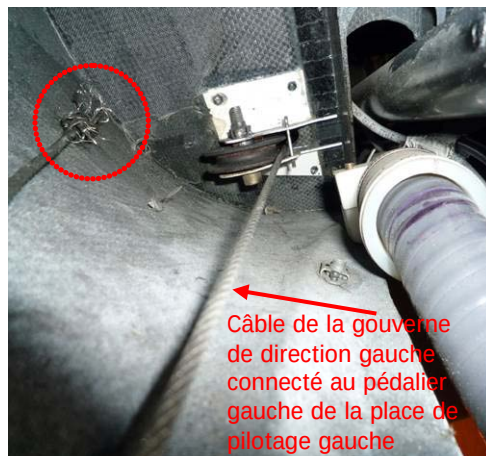
Fig. 3: Situation après la rupture du câble de direction gauche, partie arrière (cercle rouge).
