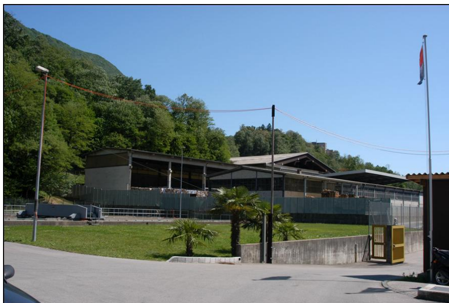
Foto 1: Veduta del campo d'atterraggio. L'effettiva superficie utilizzabile era ca. 17 x 37 m. Paragonare anche con Allegato 1
