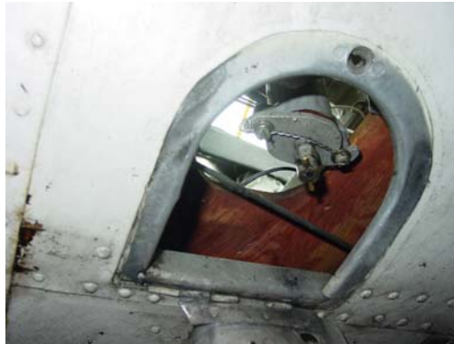
Fig 2: Purge principale placée sous le plancher de la cabine
