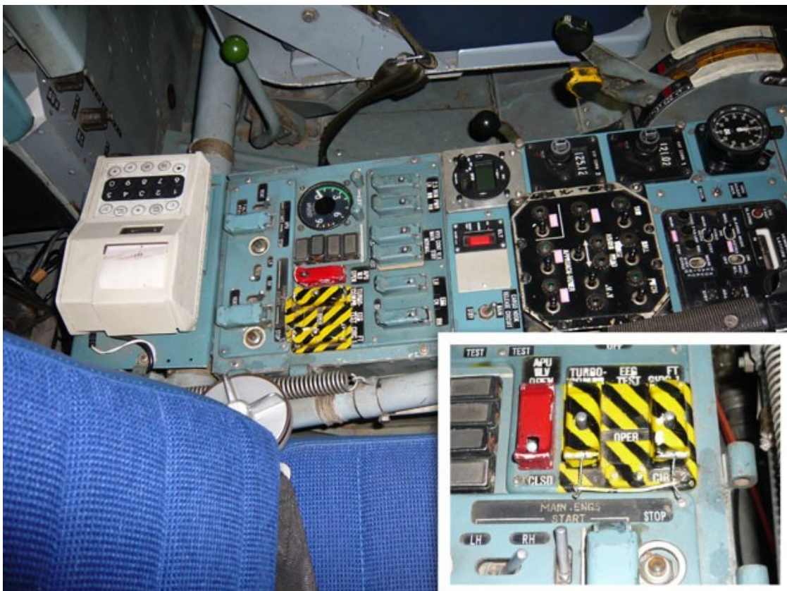
Mittelkonsole nach der Modifikation aus Sicht des Piloten auf dem rechten Sitz. Der vergrösserte Ausschnitt zeigt das Detail der Modifikation.
