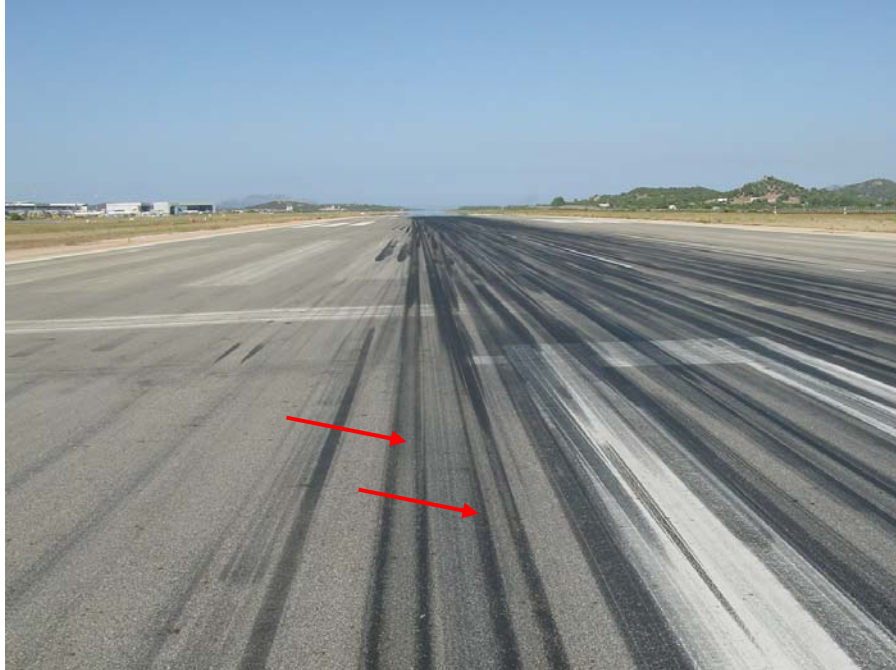
Foto n. 10: strisciate provocate dalle ruote durante l'atterraggio (indicate dalle frecce).
