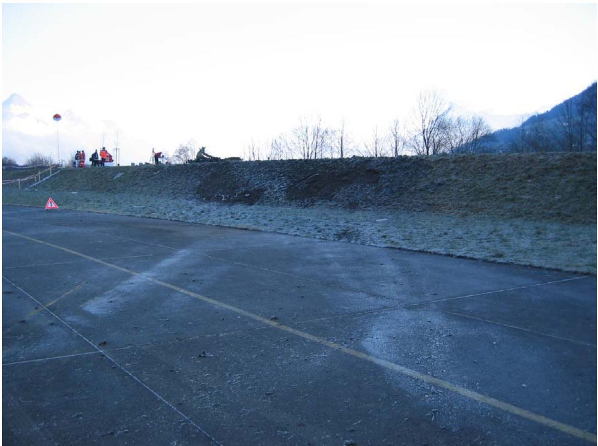
Aufschlagstelle am Damm der Engelberger Aa
