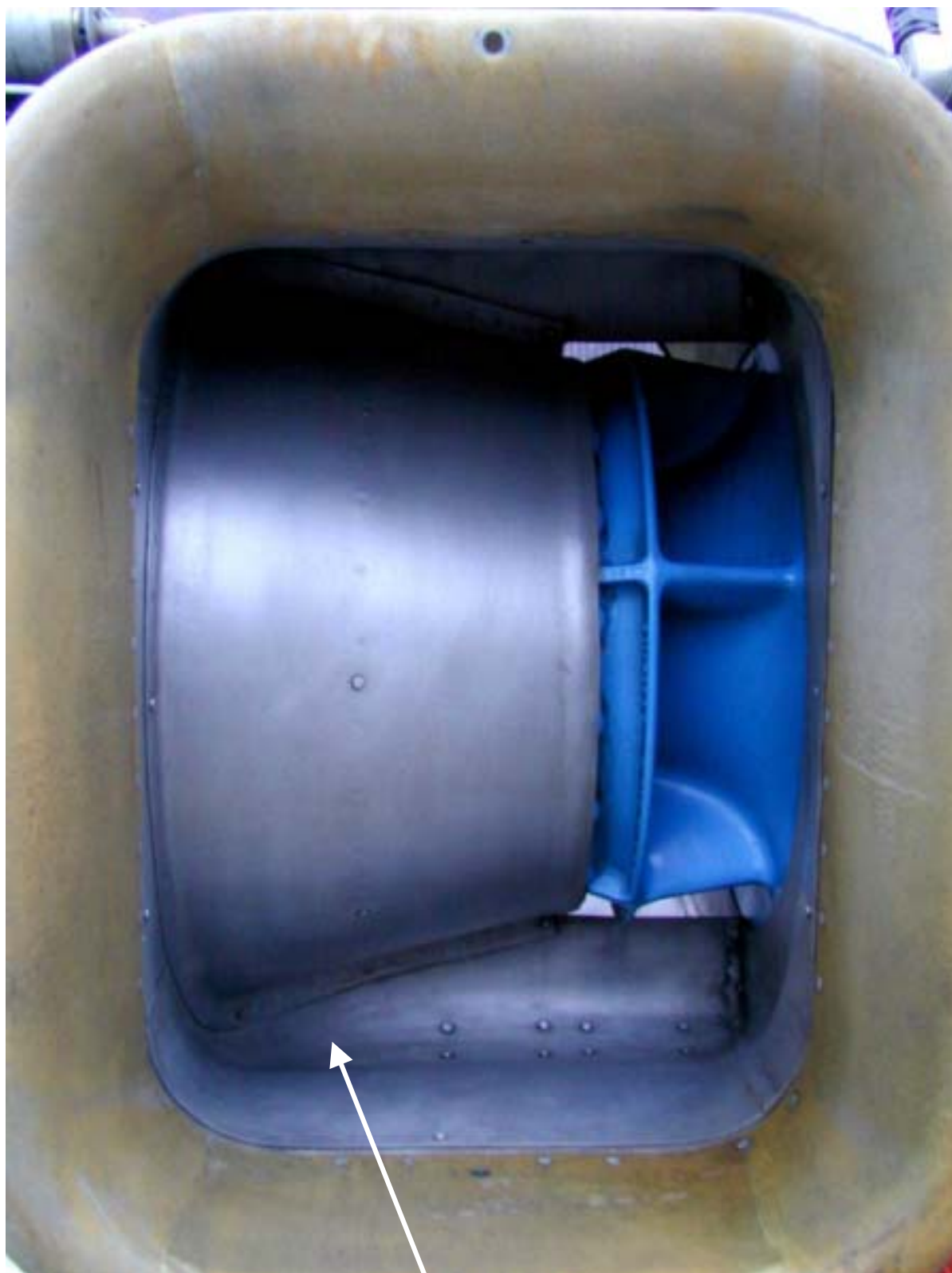
Emplacement de la plaque de glace découverte dans l'entrée d'air après démontage de la grille de protection.
