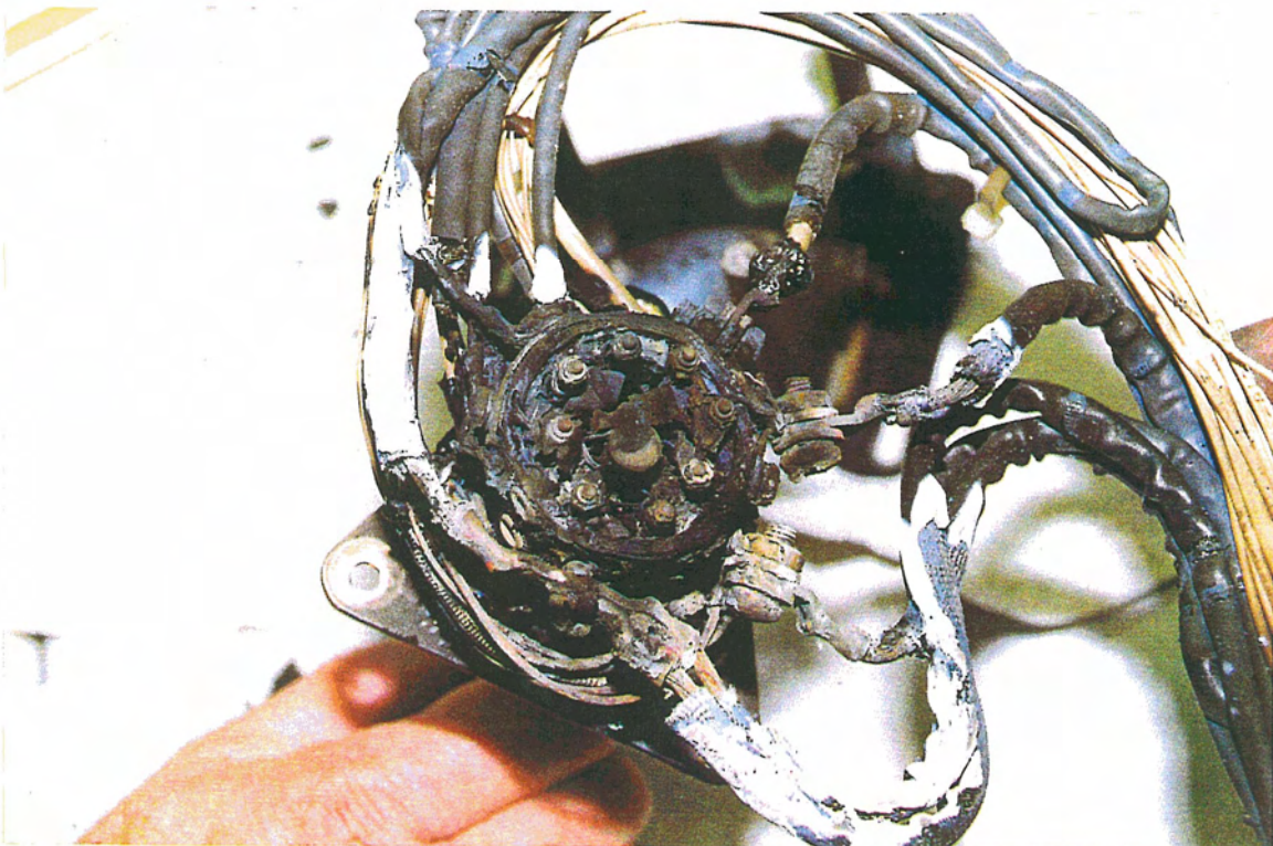
Bild 4: "Emergency Power Switch" im ausgebauten Zustand
