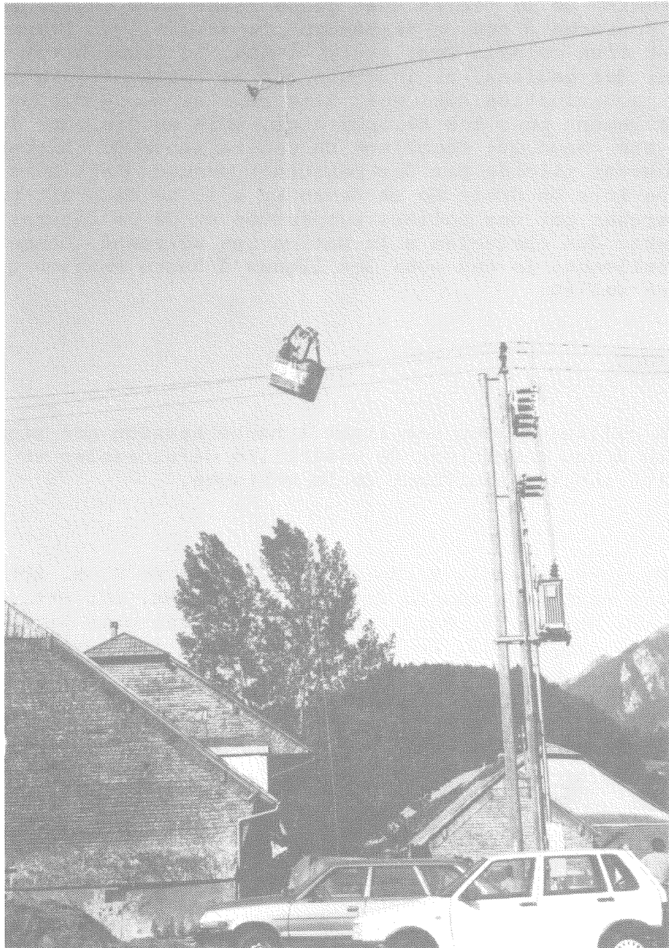
La nacelle fixée aux fils de la ligne de haute tension à Comba d'Avau
